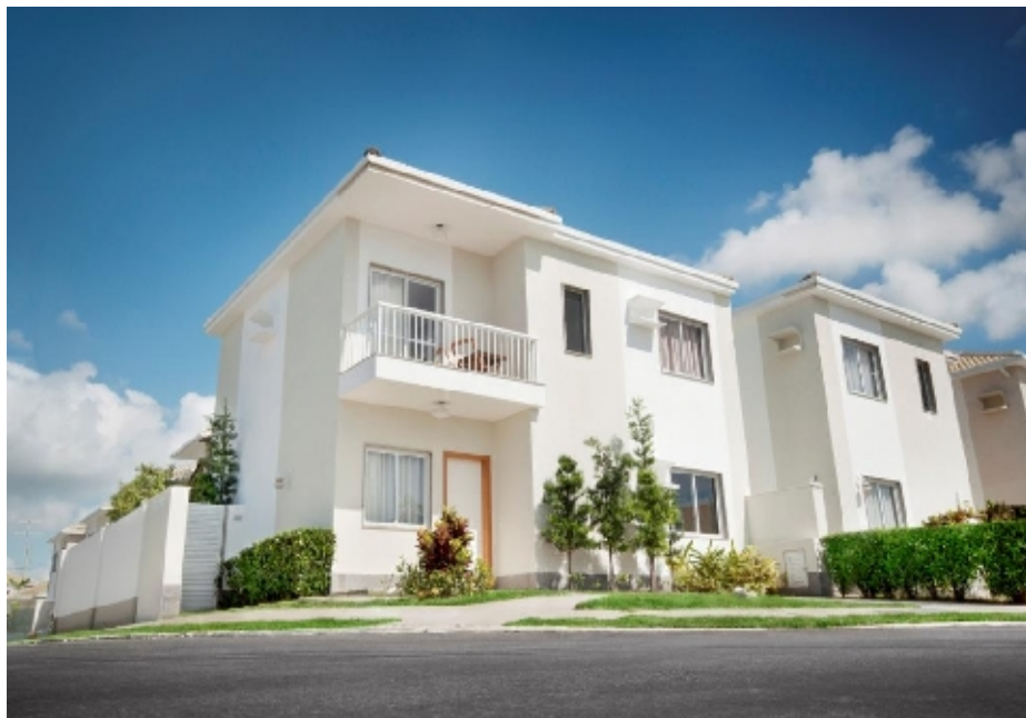
Fachada das casas A e B
